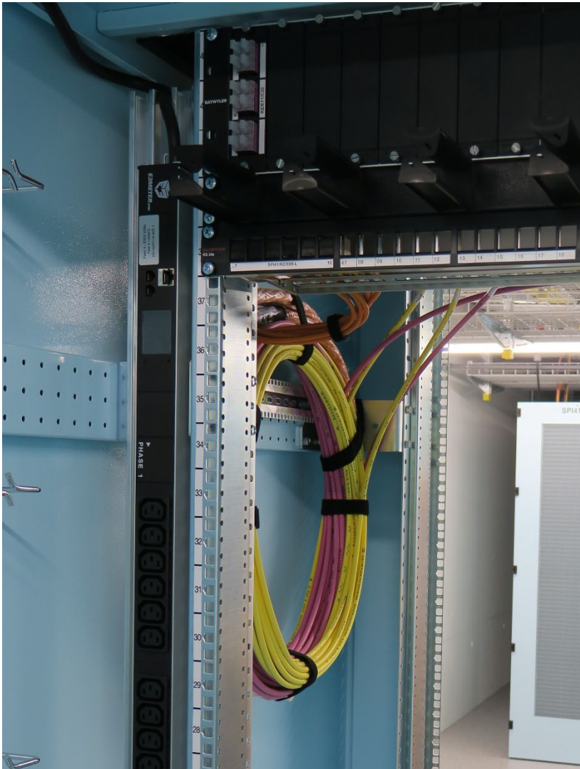
Abbildung 18 Überlängen im Rack
