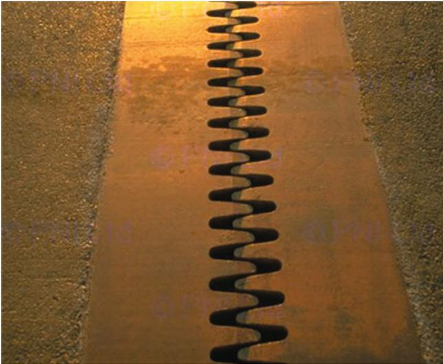
**Abbildung 13.10** Brückenbauten werden mit Dehnungsfugen ausgeführt, die die thermische Ausdehnung ermöglichen. Andernfalls würde eine enorme Spannung auftreten, die zu Verformungen führen kann. (© Frank Siteman/Stock Boston, Inc./PictureQuest.)
