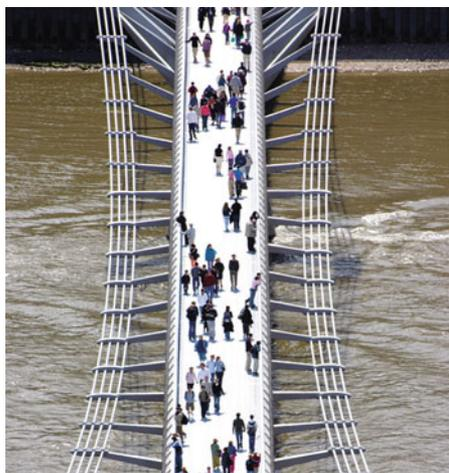
Kurz nachdem die Hängebrücke freigegeben worden war, musste man schwere Tilgungspendel unter dem Fußweg anbringen. Die Pendel sollen die übermäßigen Schwingungen verhindern, die die seitwärts gerichteten Kräfte aufgrund der Schritte der Fußgänger auf der Brücke verursachen. (© Alamy.)
