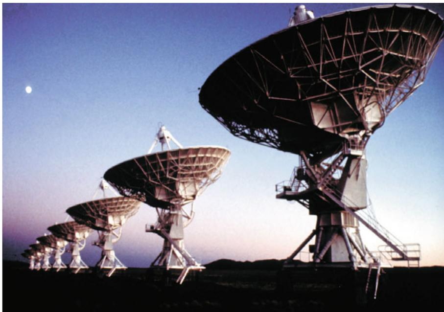
Das Very Large Array (VLA) ist ein Interferometer für astronomische Beobachtungen und steht in der Wüste von New Mexico westlich von Socorro. Es umfasst 27 Y-förmig angeordnete Teleskope und wird vom amerikanischen National Radio Astronomy Observatory betrieben. Durch elektronische Korrelation der Messdaten erreicht die Anlage die Winkelauflösung eines Teleskops von 36 km Durchmesser. (© NRAO/AUI.)
