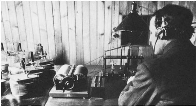
Funkgerät an Bord eines Schiffs um 1920. Links vom Funker sind die Spulen und Plattenkondensatoren des Abstimmkreises zu erkennen. (© George H. Clark Radioana Collection-Archive Center, National Museum of American History.)
