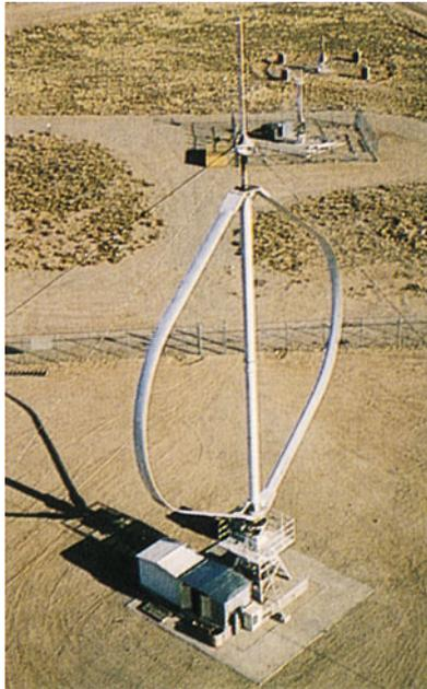
Eine vom Sandia National Laboratory in den USA betriebene Versuchsanlage zur Erzeugung von elektrischem Strom aus Windenergie. Der „Propeller“ ist so konstruiert, dass er die Luftbewegung (den Wind) optimal in die Rotation des Generators umsetzt. (© Sandia National Laboratory.)
