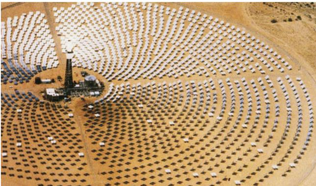
In dieser konzentrischen Anordnung zahlreicher Reflektoren wird die Sonnenstrahlung auf den Kollektor in der Mitte gerichtet. In ihm wird Sonnenenergie in Wärme umgesetzt. Diese Anlage steht in Barstow im US-Bundesstaat Kalifornien. (© Sandia National Laboratory.)
